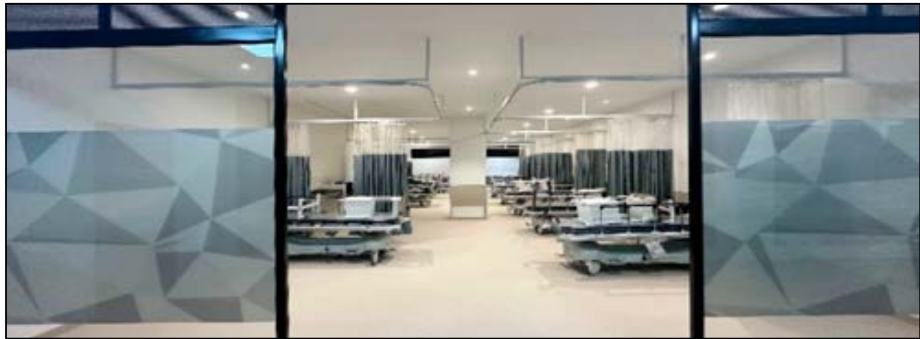
Figura 71. Adecuación de Módulos de urgencias
