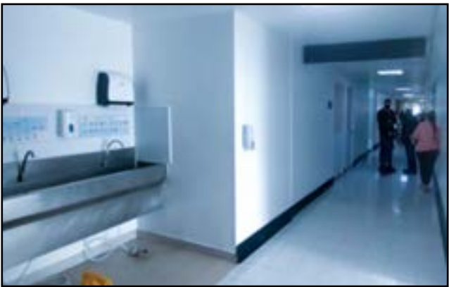
Figura 74. Adecuación de infraestructura servicio pretrasfusional
